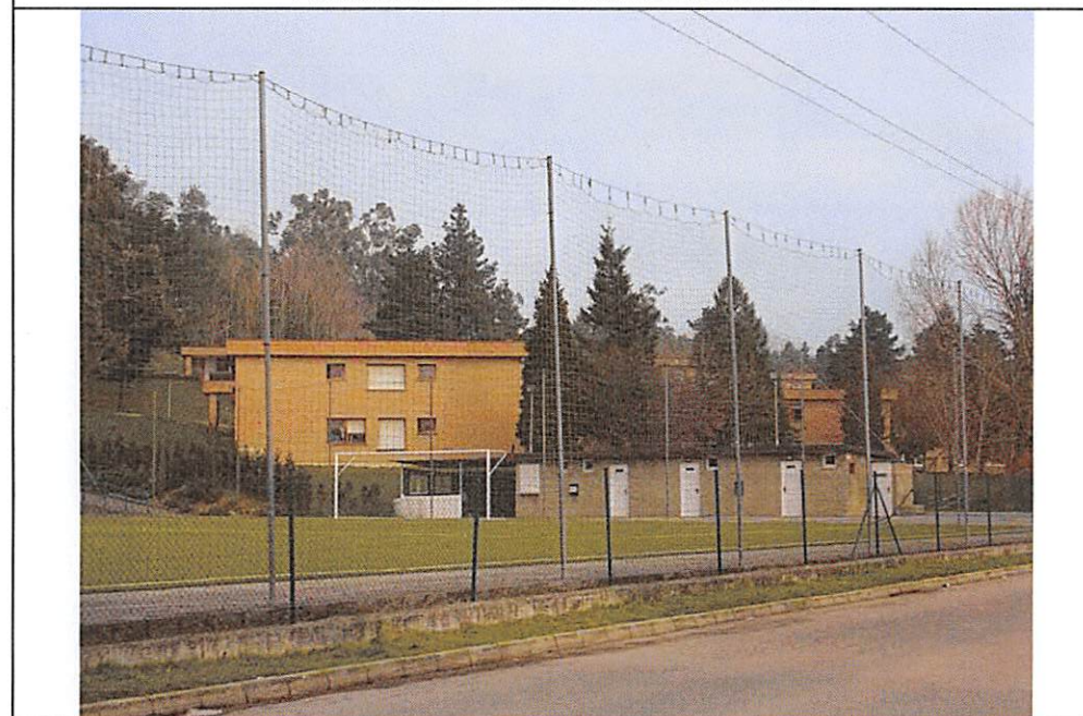
FOTOGRAFIA DE LA CONSTRUCCIÓN
