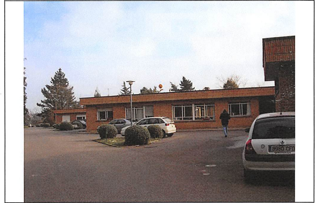
FOTOGRAFIA DE LA CONSTRUCCIÓN
