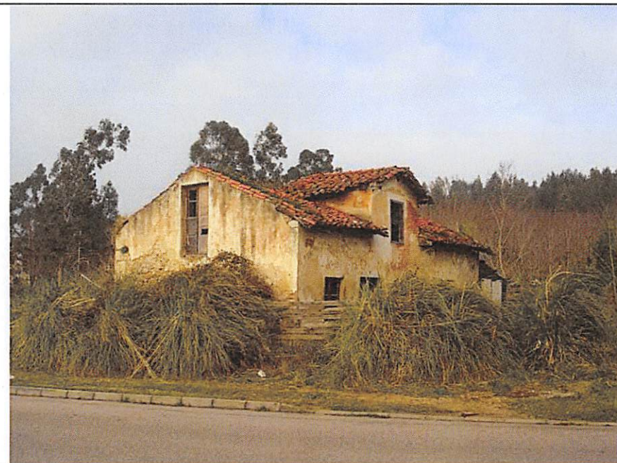
FOTOGRAFIA DE LA CONSTRUCCIÓN
