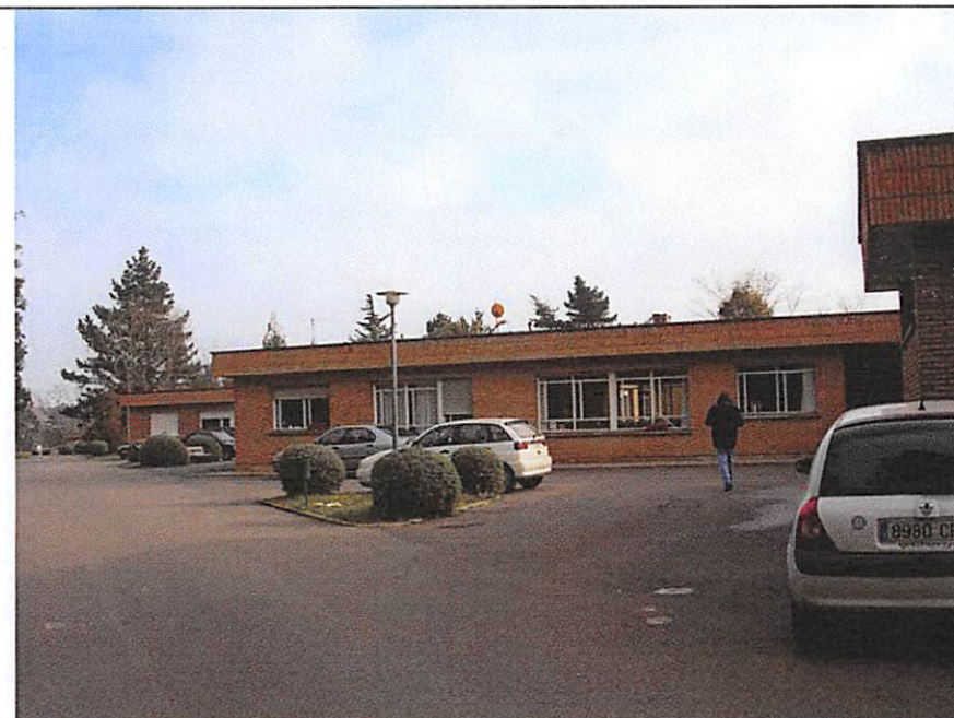
FOTOGRAFIA DE LA CONSTRUCCIÓN
