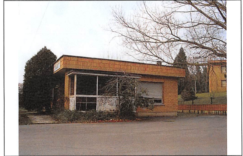
FOTOGRAFIA DE LA CONSTRUCCIÓN
